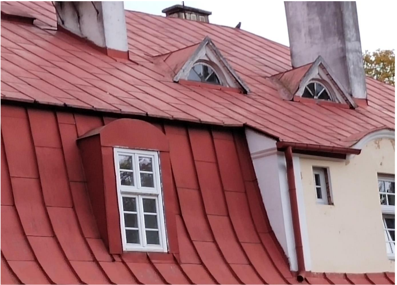
Stan zachowania dachu i obróbkę blacharskich lukarn okien dachowych i kominów
