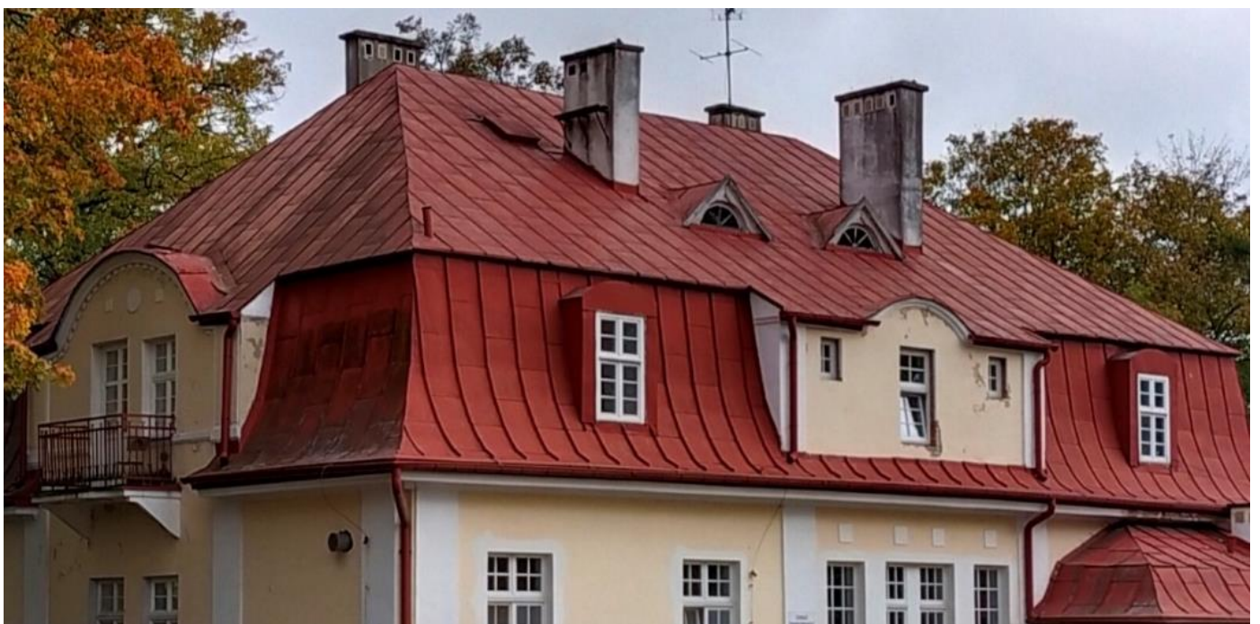
Stan zachowania dachu i elewacji od strony północno - zachodniej
