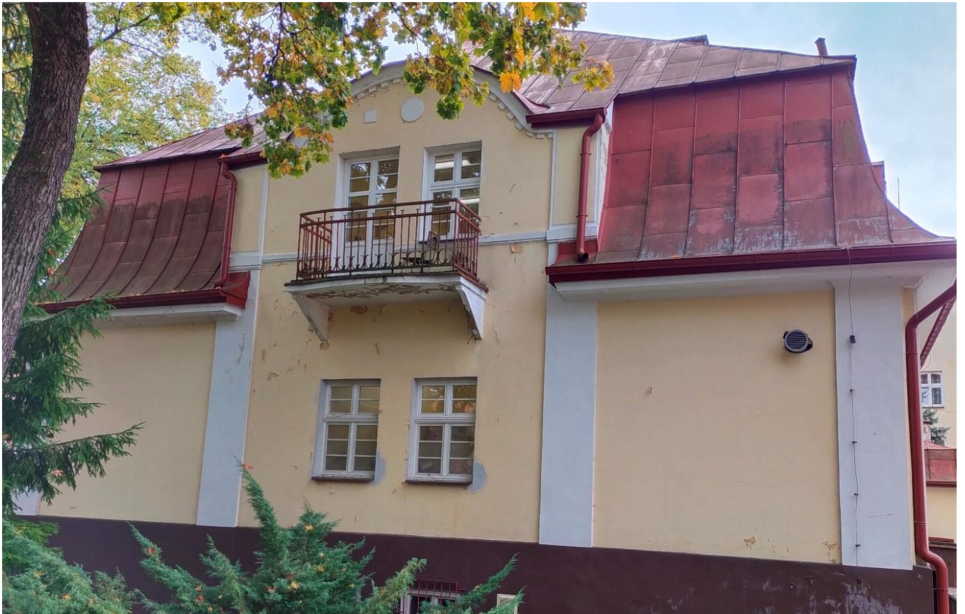
Stan zachowania dachu i elewacji – widok od strony Komendy Powiatowej Policji
