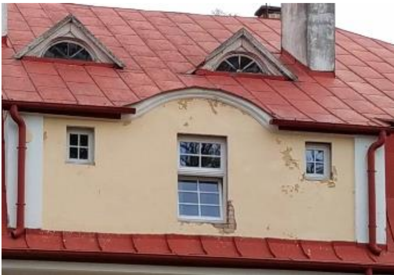
Stan zachowania elementów dachu od strony zachodnio - południowej
